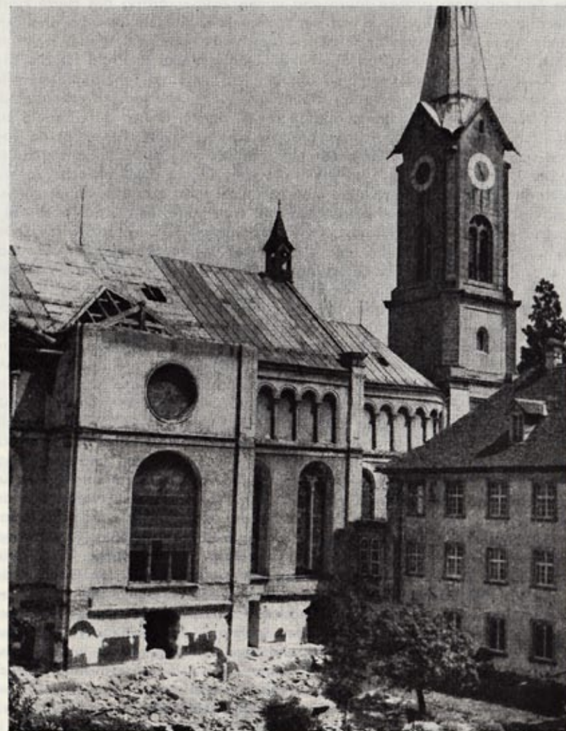
Die Kirche im Umbau (Juni 1961)
